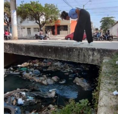
*Ilustración 15 obstrucción del flujo de por acumulación de residuos sólidos con los muros del puente o box culvert vehicular, en el paso por la avenida Pedro Romero.*
