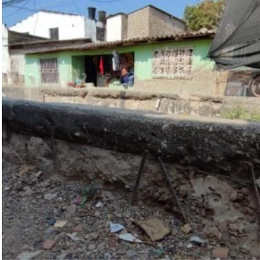
*Ilustración 13 desprendimientos parciales del concreto y acero expuesto y con pérdida casi total de su sección transversal debido a la corrosión*
