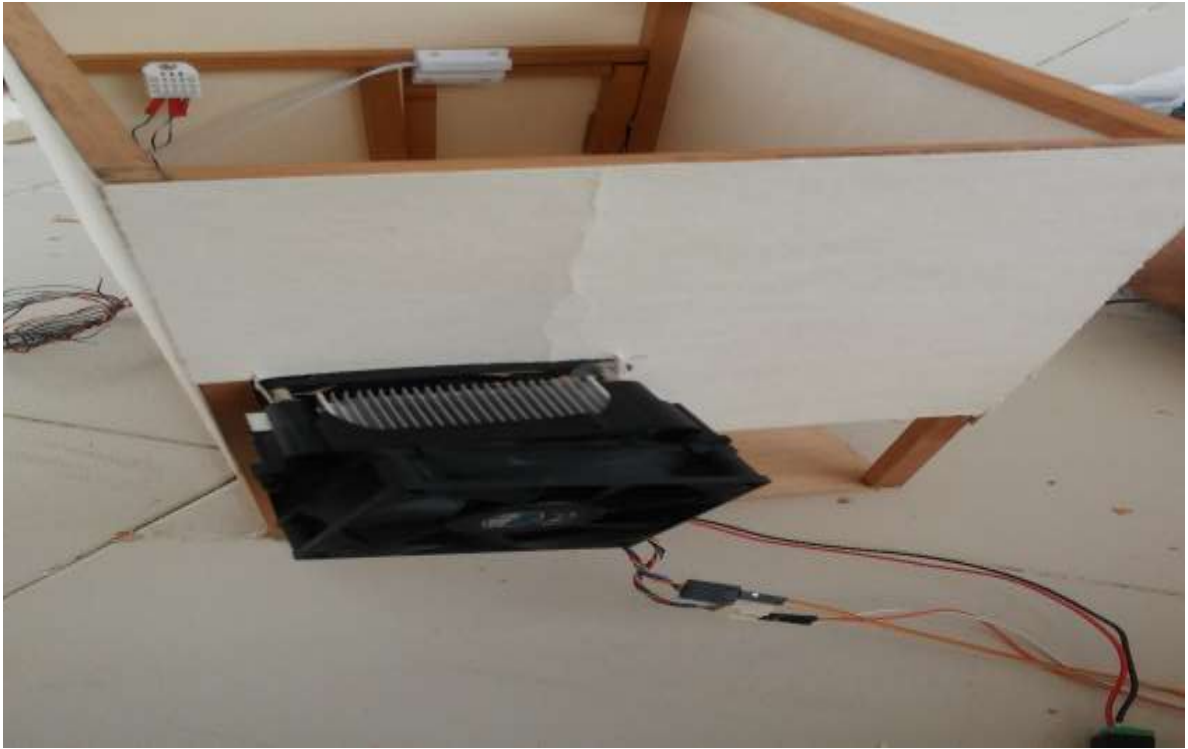
Ilustración 26. Instalación de sistema de refrigeración externa.
