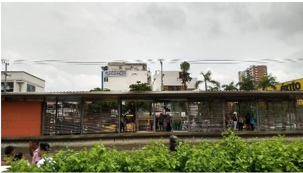
anexo 4.Puertas deslizables. Fuente. Elaboración propia.
