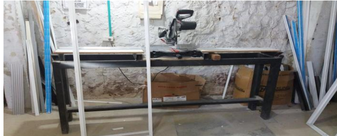
Figura 9. Área de corte de perfilería.
