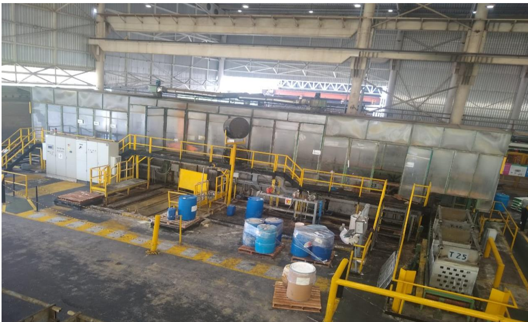
Figura 3. Vista área fosfatizado en la Fábrica de cuplas.
